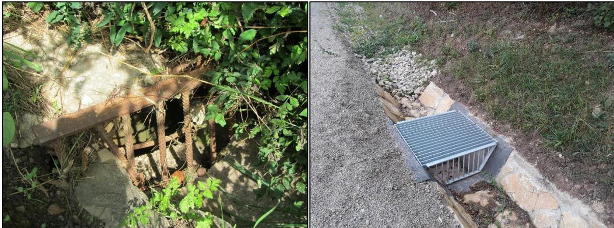
Abbildung 63: Aktuelles Einlaufbauwerk (links) und Beispiel eines zweidimensionalen Einlaufbauwerkes (rechts)
