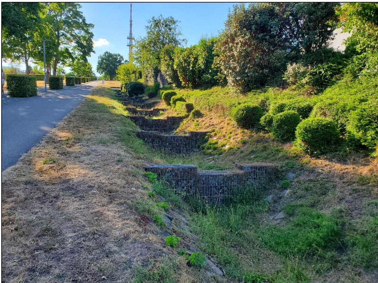
Abbildung 62: Beispiele für kaskadenförmigen Graben
