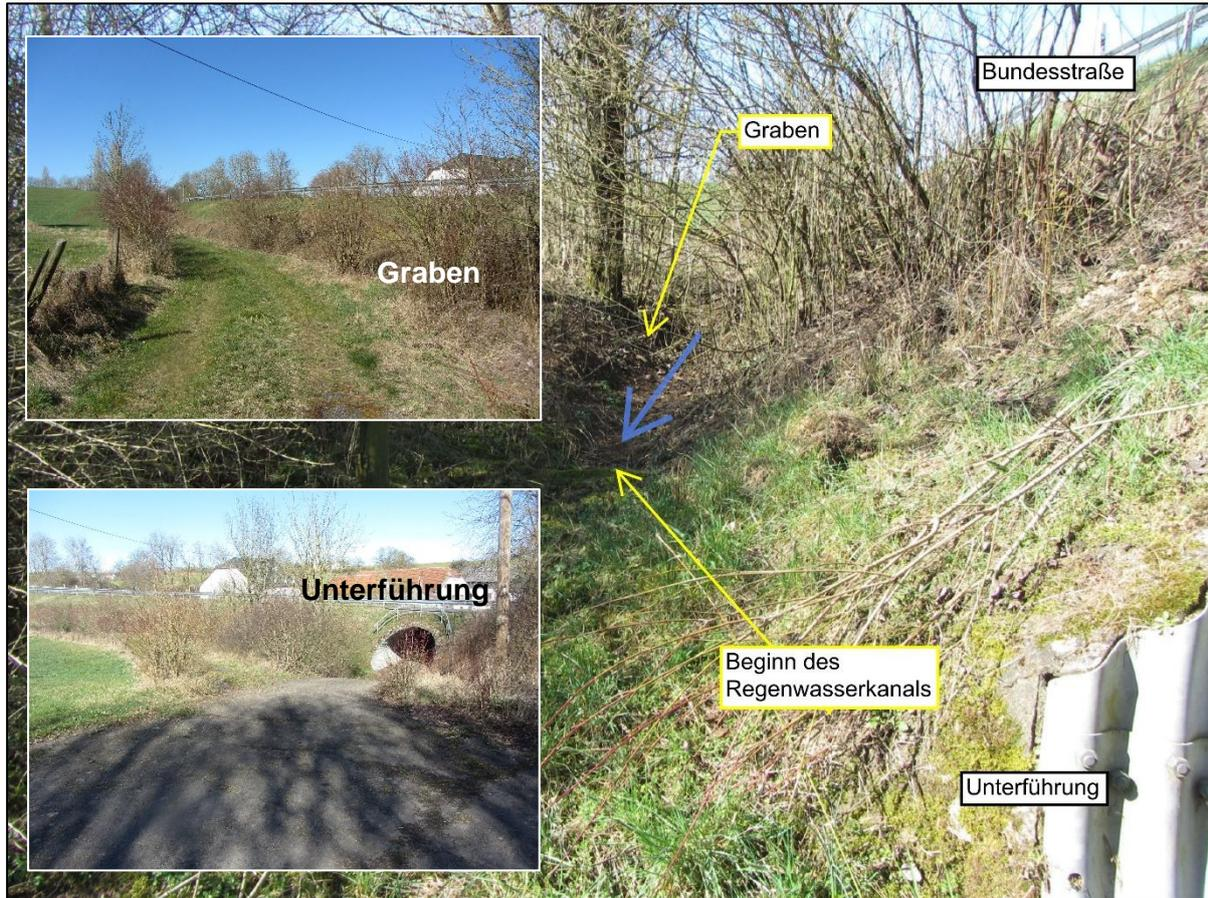
Abbildung 78: Entwässerungsgraben im Bereich der Unterführung
