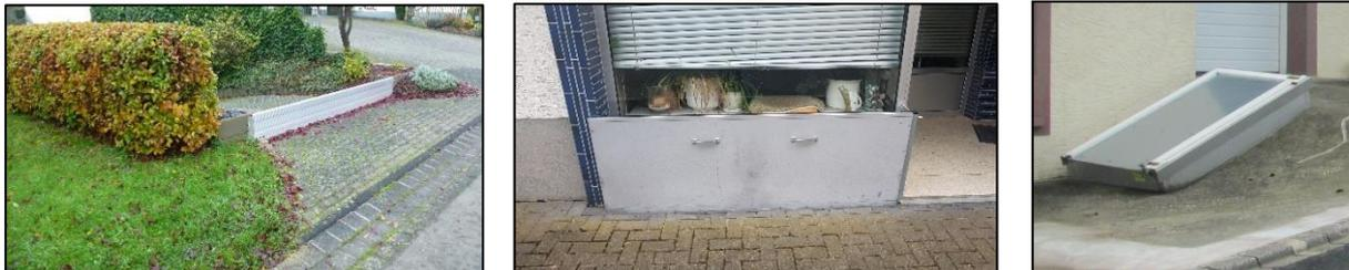
Abbildung 21: Beispiele von Objektschutzmaßnahmen (mobile Steckelemente, Dammbalkensysteme, Abdichtungen)
