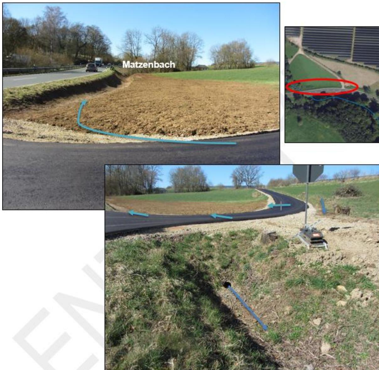
Abbildung 88: Situationsentschärfung durch Anpassung der Wegneigung
