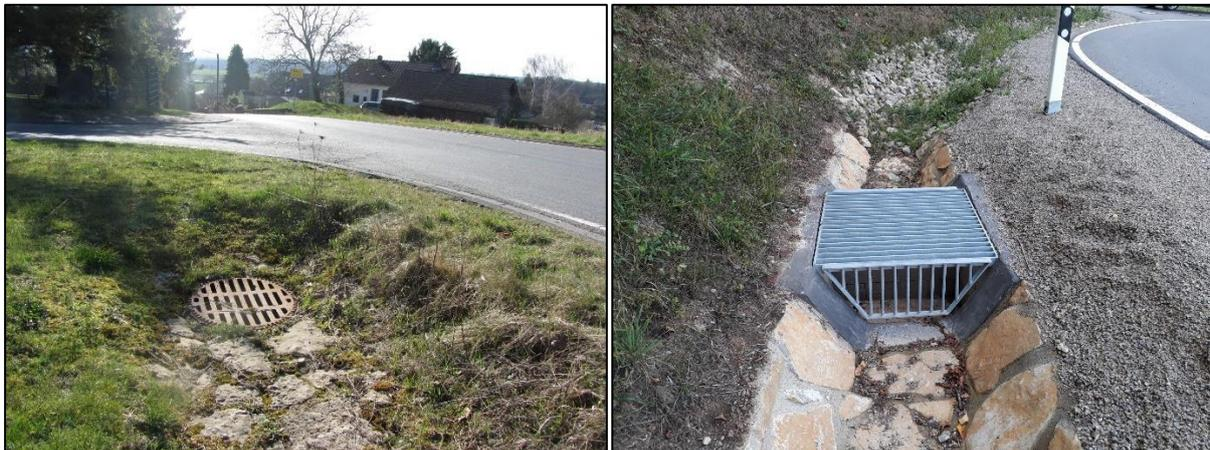
Abbildung 49: Aktuelles Einlaufbauwerk (links) und Beispiel für ein zweidimensionales Einlaufbauwerk (rechts)
