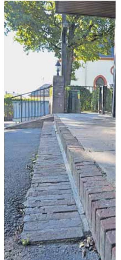
Projekt Friedhof: Diese Treppenstufen sollen weg.
